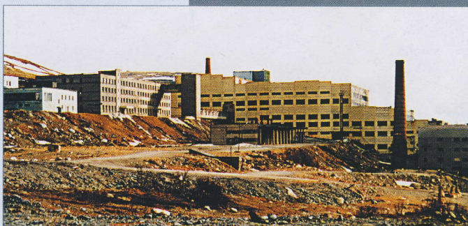
Промплощадка рудника «Умбозеро»
